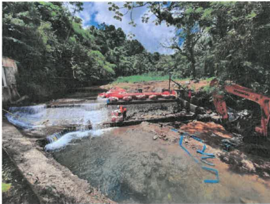
Figure 16 - photo d'un batardeau en rive gauche pour effectuer des travaux sur une prise d'eau
